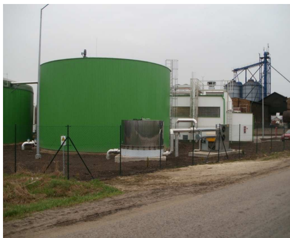
Biogazownia w Skarztuszu z gorzelnią
