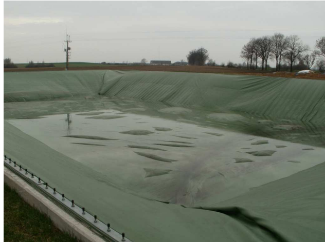
Laguna na substancję pofermentacyjną z membraną wyłapującą resztki metanu
