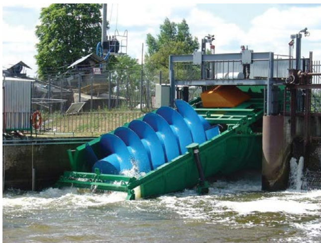
Fot.5. Turbina ślimakowa, woj. mazowieckie
