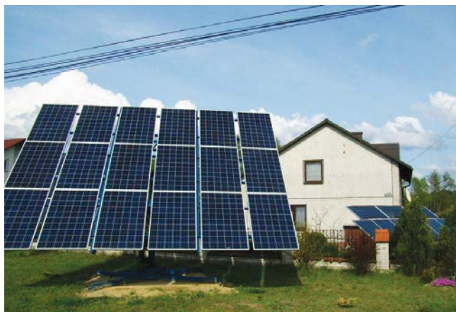
Fot.3. Nadążna fotowoltaika na trakerach, woj. podkarpackie
