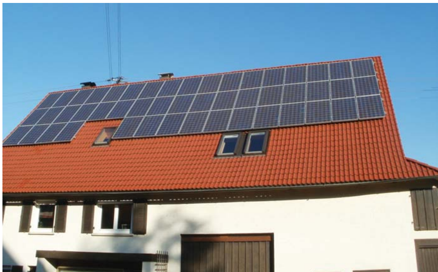
Fot. 4. Panele fotowoltaiczne zamontowane na dachu budynku inwentarskiego w woj. wielkopolskim.
